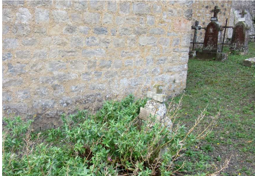
Vue actuelle du mur du clocher
